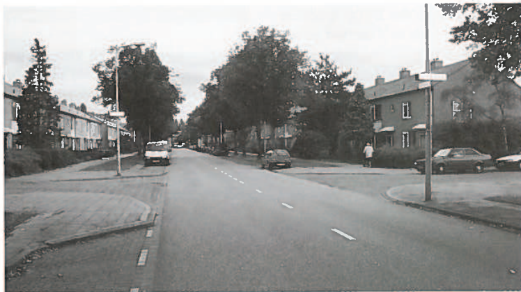
ALLERWEERSCHIL: DE WEGGEBRUIKER OP DE ASFALTWEG HEEFT AL SNEL TEN ONRECHTE DE INDRUK VOORRANG TE HEBBEN OP VERKEER VAN RECHTS
